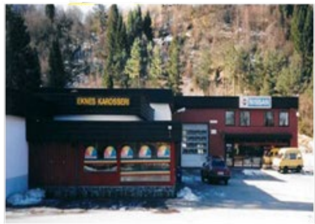
Deler av bygget til venstre var 1ste byggetrinn. Fasade mot gammel riksvei
